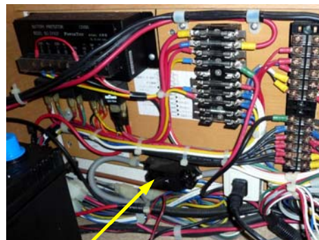
ブレーカー(サードシート下部)
